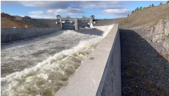
Betongkanal Foto: D Ygland
