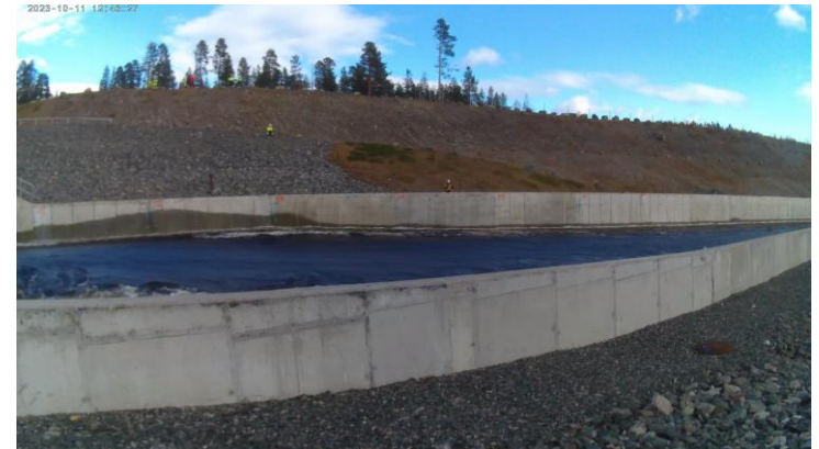
Betongkanal H sida. Fast montage
